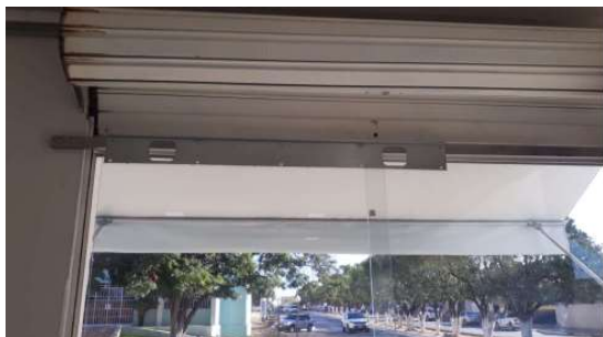
Antes da instalação de cortina de ar
