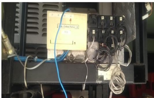
Imagem dos painéis de entrada a serem substituídos pelo patch panel
