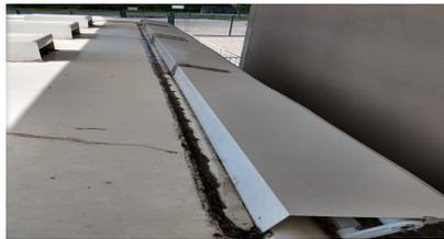
Imagem do modelo de rufo a ser instalado
