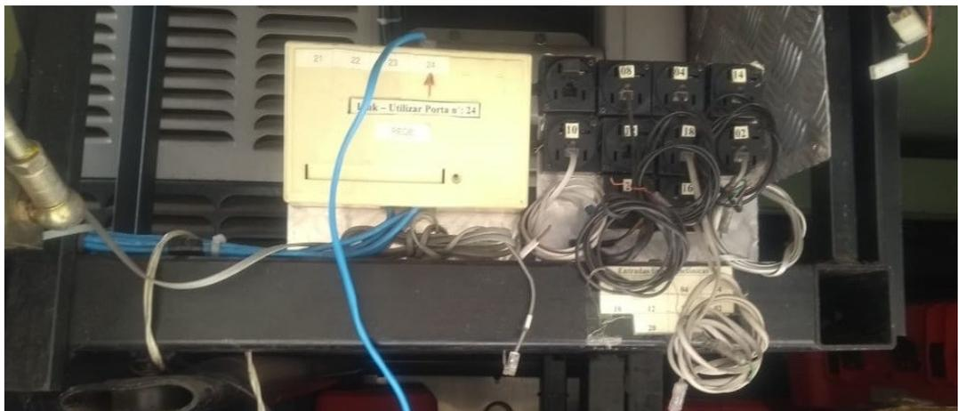
Imagem dos painéis de entrada a serem substituídos pelo patch panel
