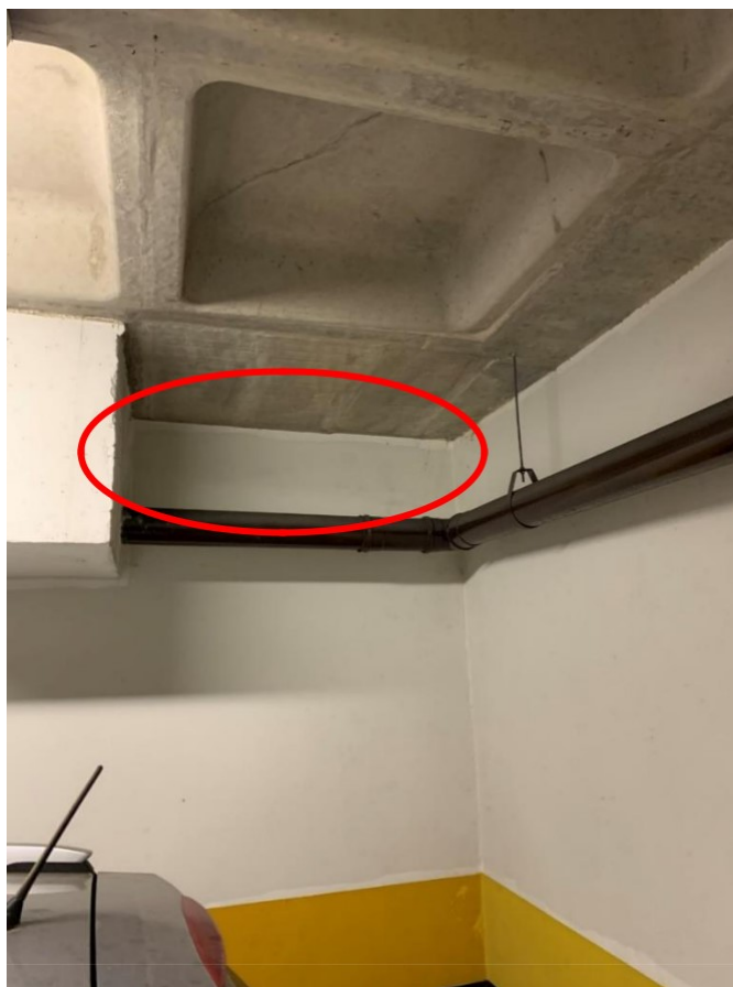
Figura 9: 1º subsolo – Local para instalação de subida para o térreo da tubulação de gases
