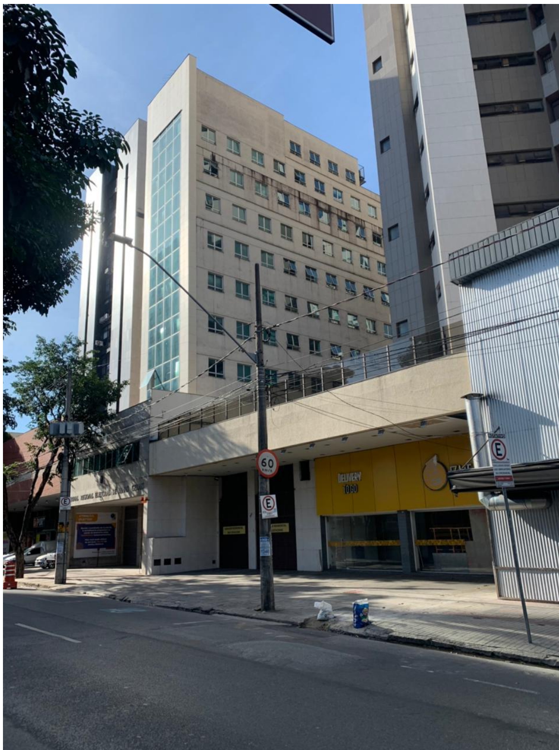
Fachada Lateral Direita
