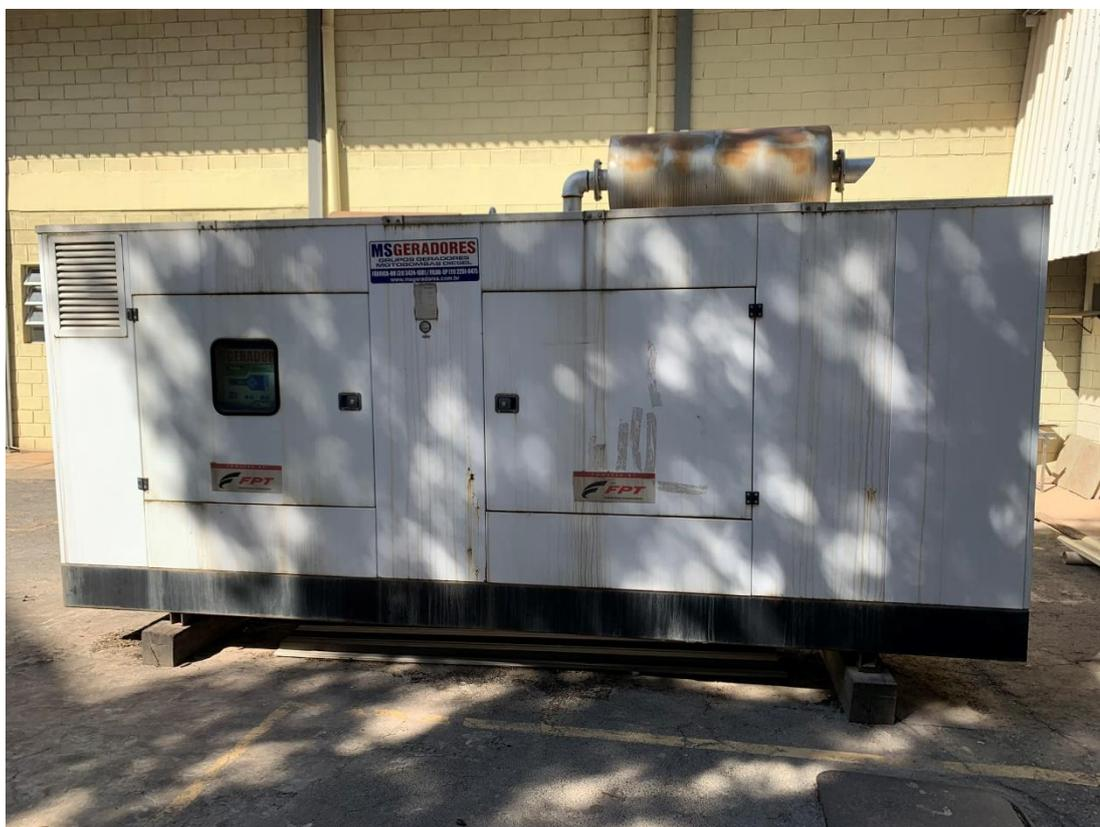
Figura 11: Gerador cabinado à diesel, potência 450 kVA.
